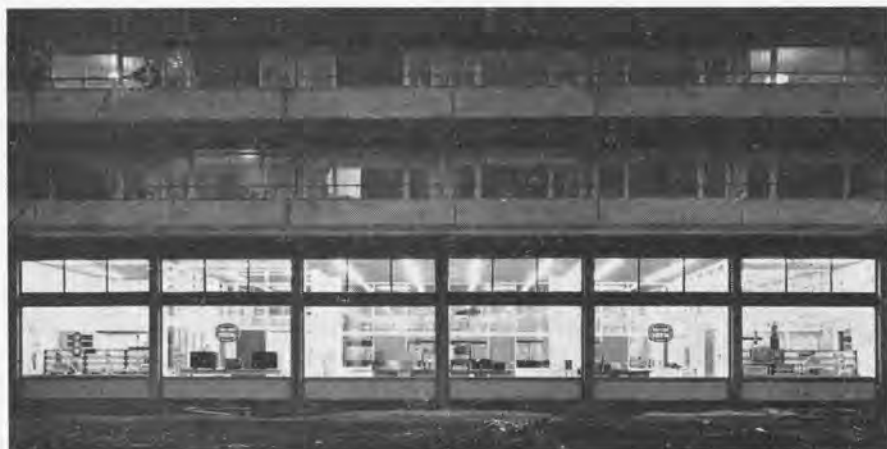
De nog niet geheel afgewerkte torenflat in Maastricht, op de begane grond waarvan onze Technische Dienst zojuist haar intrek heeft genomen.
