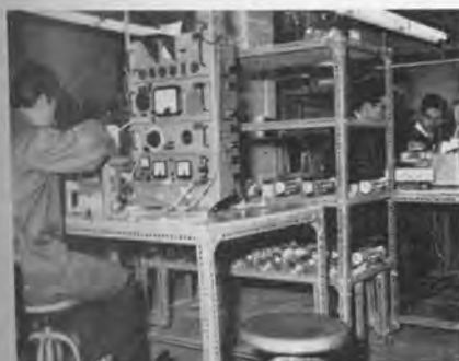
Een van de toestellen wordt aan de meetkast gecontroleerd.
