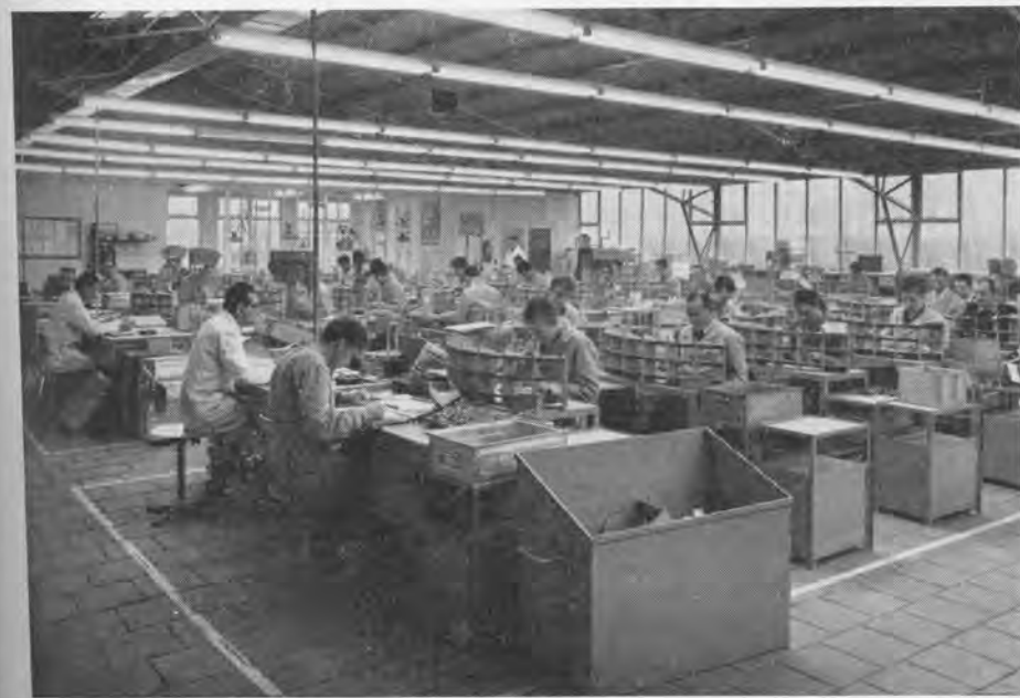
De montagehal in Sneek, waarin steeds meer werknemers hun plaats hebben ingenomen. Achterin de zaal — achter het plantenrek — bevindt zich de kantine.
