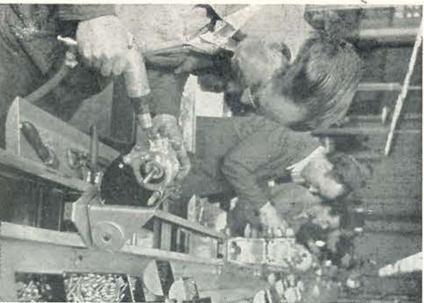
Vaardige handen monteren onze veel geroemde Solex-motor.
