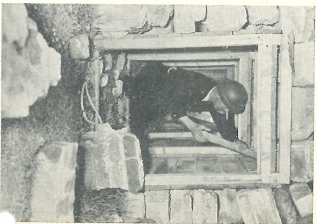
Het bouwen van een tunnel door puinhopen heen, door de Opruim- en Reddingsdienst.
